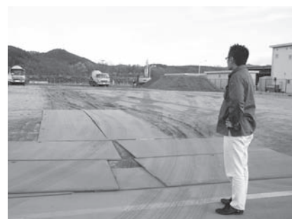
整地中の新事務所敷地
