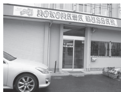
事務所玄関付近
